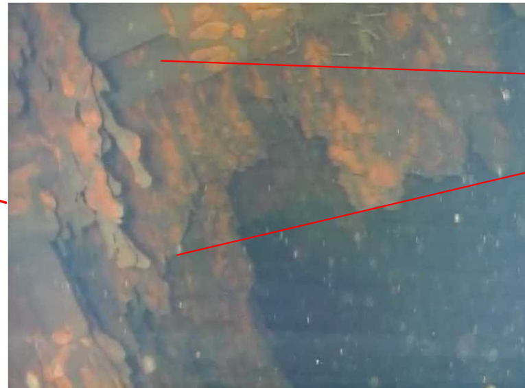
3号機 CRDハウジング 近傍 <カメラ向き 水平>
