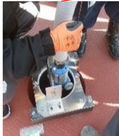
配管内アクセス装置挿入(3階)
