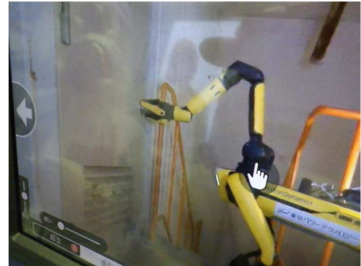
2階操作室扉開放の状況
