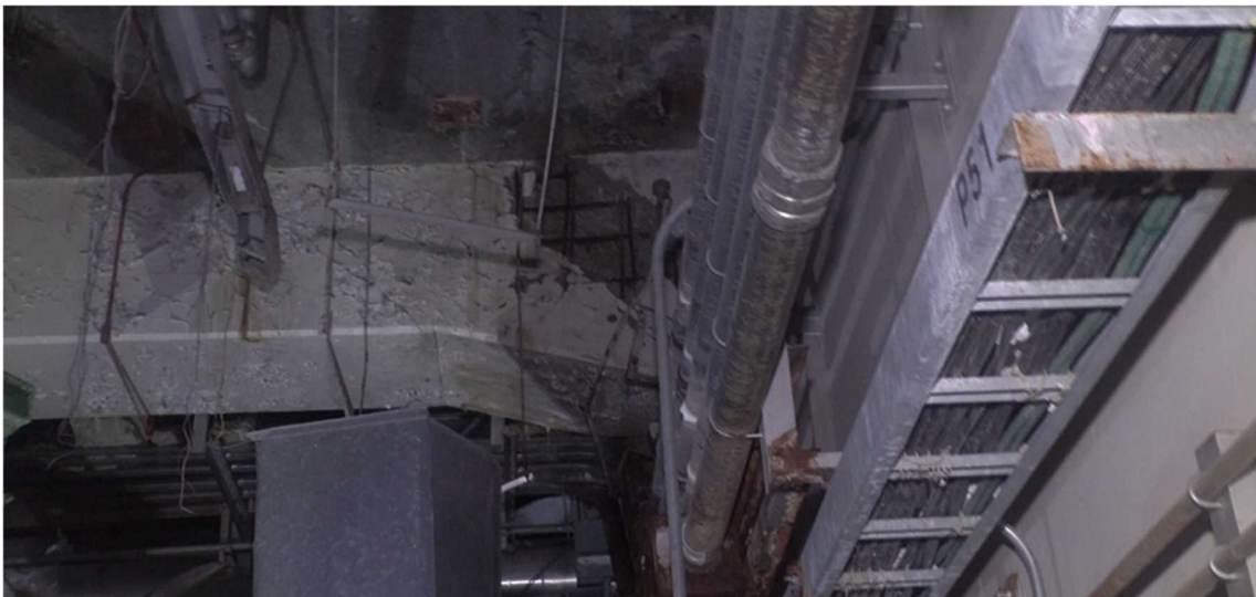
図 46 IC の南側付近の梁（1号機原子炉建屋4階）（IC（B系）の上部）
