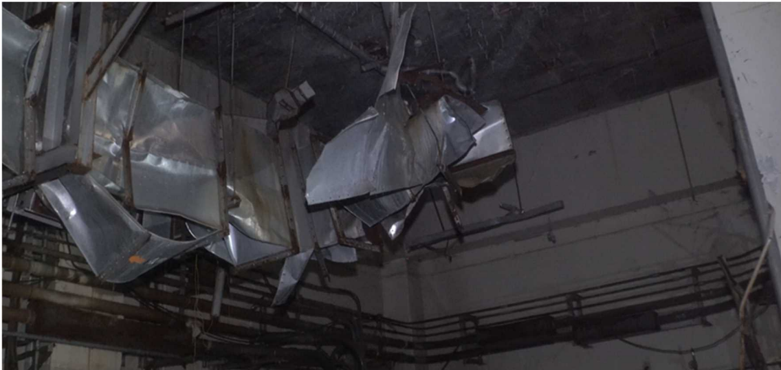
図 54 天井付近のダクト（1号機原子炉建屋4階）
