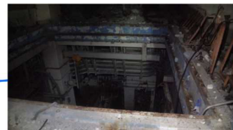
(大物搬入口付近の様子)
