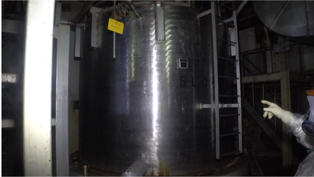
図 59 SLC タンク（北東側フロア）
