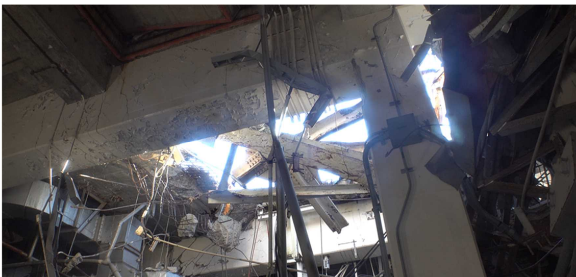
図 28 IC の北側付近の天井
