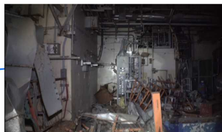
(大物搬入口付近の様子)
