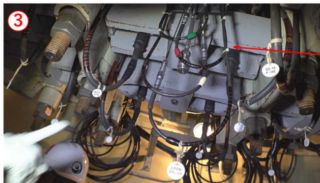
図5 SRNM/LPRM ケーブル（同軸ケーブル）の設置状況
