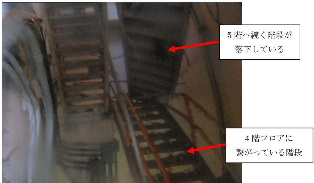
図 22 4階から5階に向かう階段の状況（北西側）
