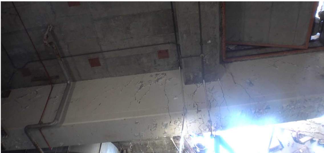
図 34 IC の北側の壁に近い天井付近の梁
