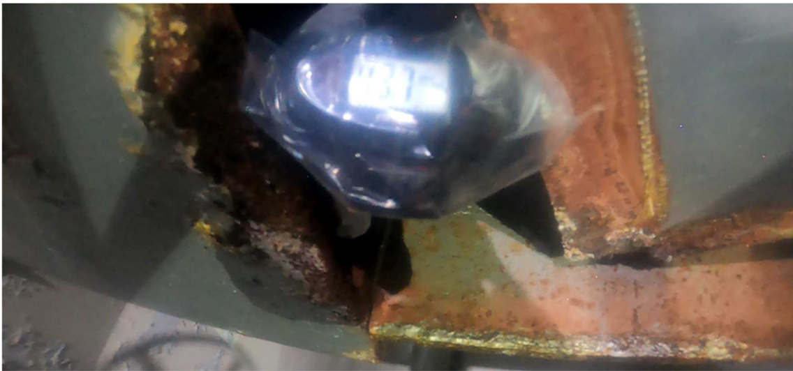
図 16 測定対象配管付近の線量率
