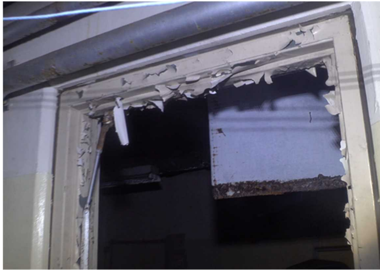
図4 1号機原子炉建屋3階東側の部屋（CRD リペア室）の入口付近の状況 （ドア枠上部）
