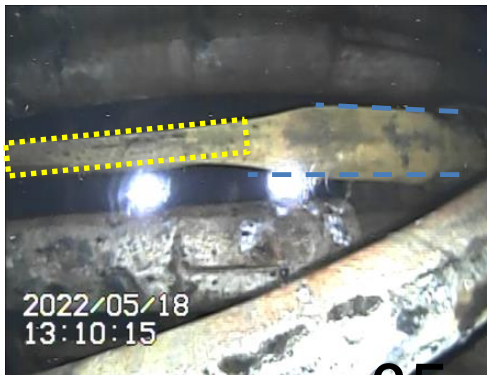
水面より上のRCW配管の状況
