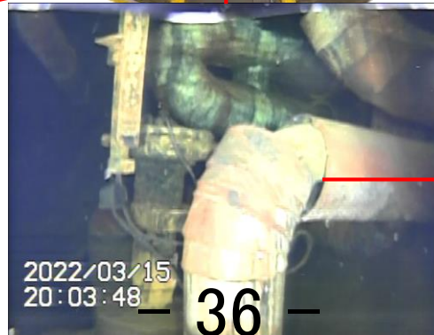
格納容器貫通部付近のRCW配管(水中)
