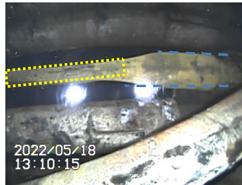
水面より上のRCW配管の状況
