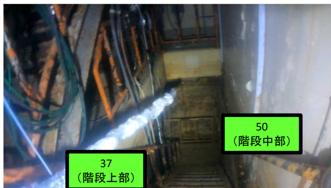
中地下階～地下階への階段
