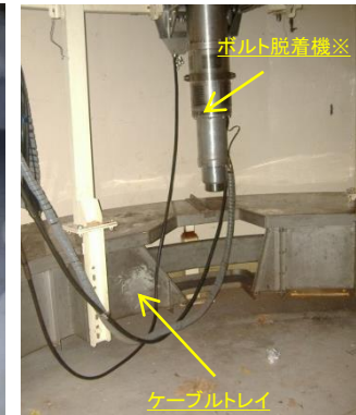
(参考) 2号機定検時 ※運転時には上記構造物はPCV内より撤去
