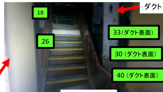
トーラス室入口
