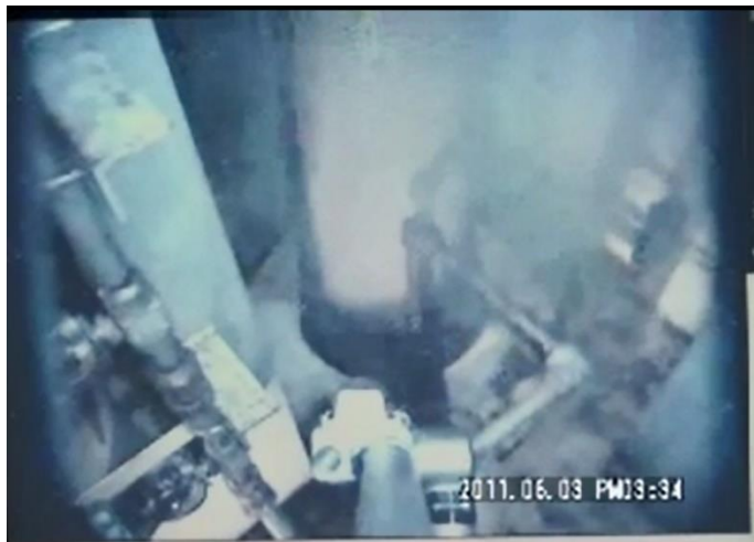
南東エリアの床貫通部で確認された湯気 (2011年6月撮影)
