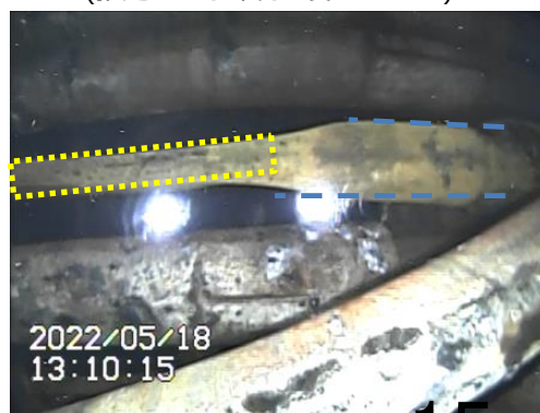
水面より上のRCW配管の状況
