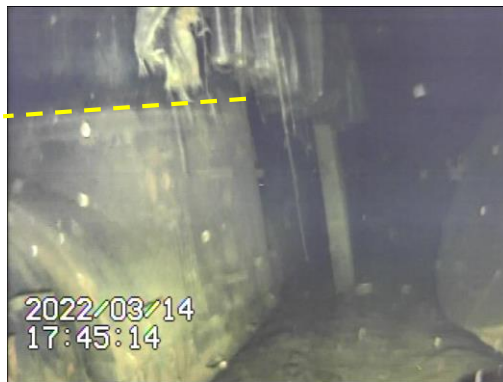
E: 真空破壊弁からの水漏えいが確認された ベント管のジェットデフレクター
