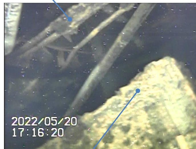
水中の構造物に付着した堆積物 (機器ドレンサンプの遮蔽体)
