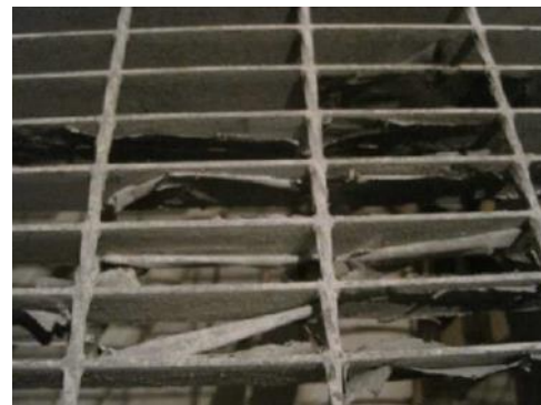
福島第二4号機で確認されたグレーチングからの亜鉛塗料の剥離（推定される環境温度 ~150°C）
