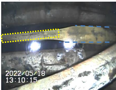
水面より上のRCW配管の状況
