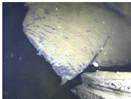
E: 真空破壊弁からの水漏れが確認された バント管のジェットデフレクター
