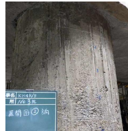
No.3杭上部の状況
