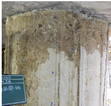
No.2杭上部の状況
