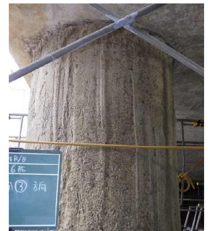
No.6杭上部の状況
