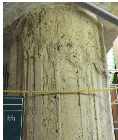
No.5杭上部の状況
