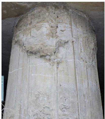
No.4杭上部の状況
