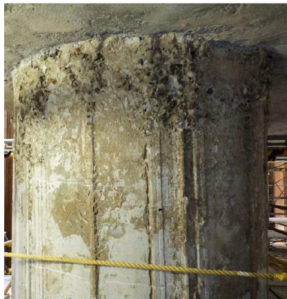
No.1杭上部の状況
