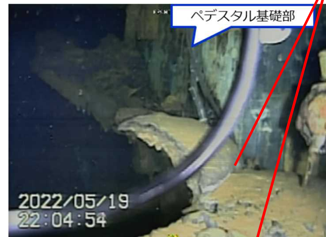
A. ペDESTAL開口部付近
