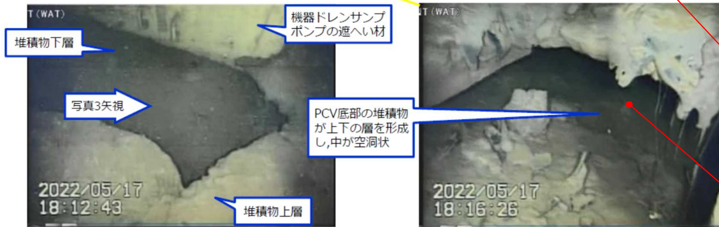
写真2.PCV底部の堆積物の状況
