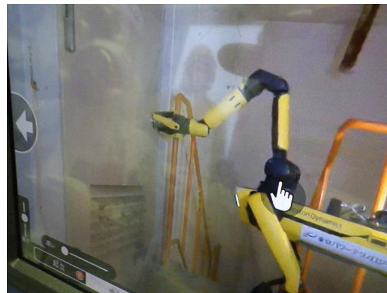
2階操作室扉開放の状況
