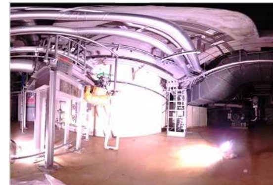
3階シェル壁北東面（写真）
