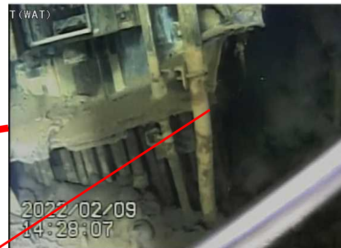
ペDESTAL開口部付近の状況(俯瞰)
