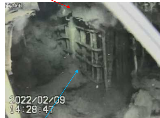
A. ペDESTAL開口部付近
