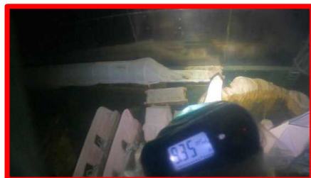
(DSピット内部)
