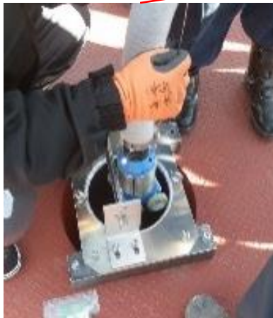
配管内アクセス装置挿入(3階)
