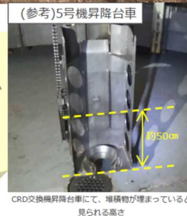
(参考)5号機昇降台車 CRD交換機昇降台車にて、堆積物が埋まっていると見られる高さ
