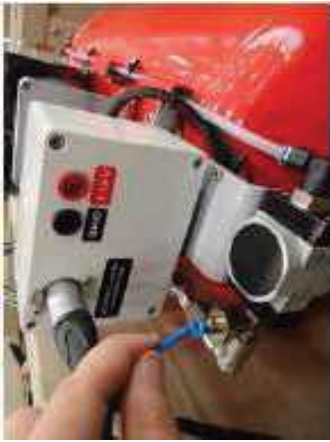
図 2.9.31 コントロールワイヤーをコンプレッサーコントロールボックスに接続
