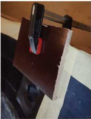
図 5.10 F 字クランプで補修エリアに圧力を加える
