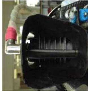
図 7.5.5 ダクトフラップが「Open」の状態
