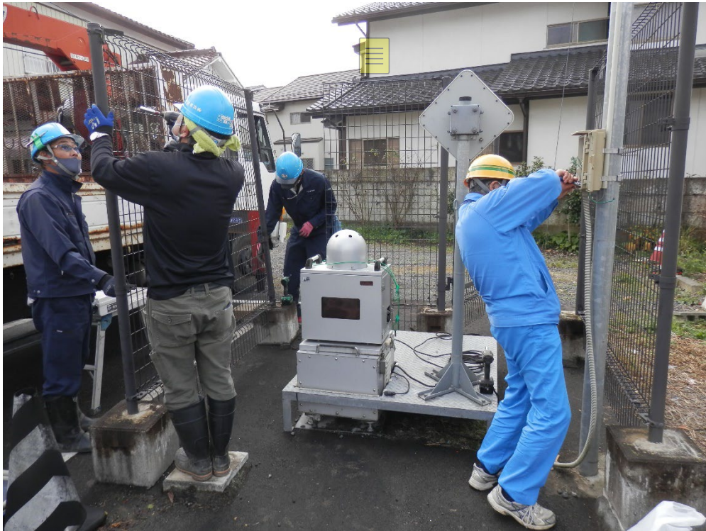
図2-10-11(2) 移設作業の様子 (須賀川市役所 (須賀川市) : 2021年11月8日撮影)
