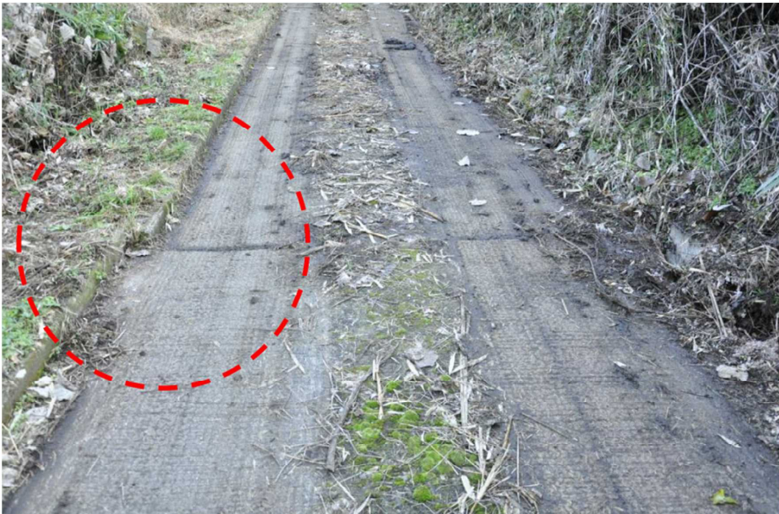
図 2.1.28 2017 年土林トレンチ周辺の現地写真②
