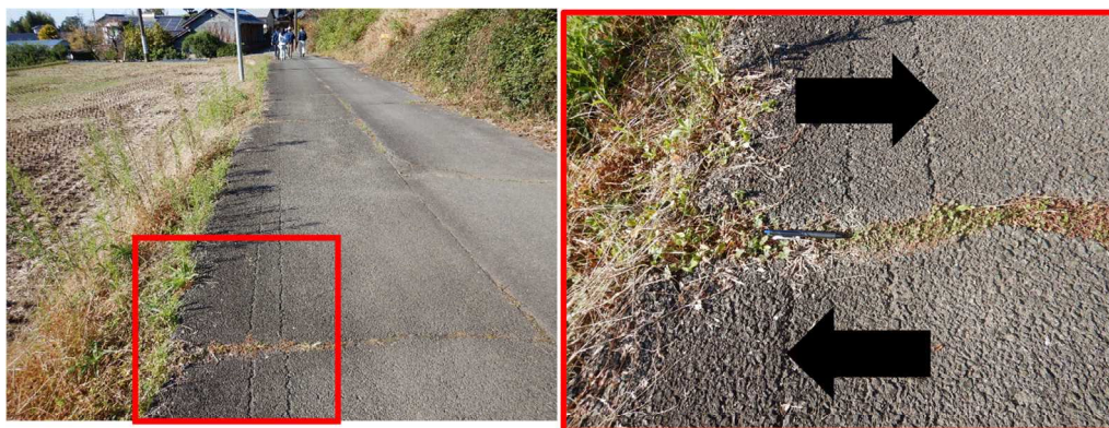
図 2.1.23 2017年福原トレンチ周辺の現地写真
