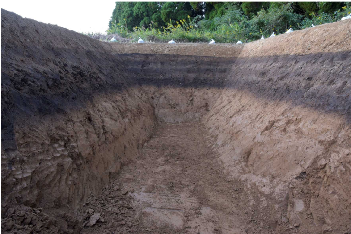
図 2.2.41 北側トレンチ掘削状況
