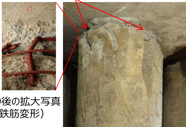
図31 No.8杭頭部の損傷状況
