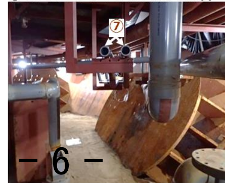
⑦ ジェットデフレクタF前の電線管
