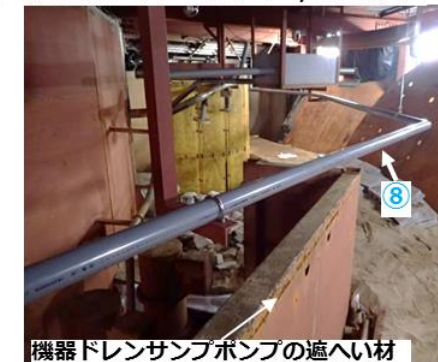
⑧ ジェットデフレクタF,Eの電線管
