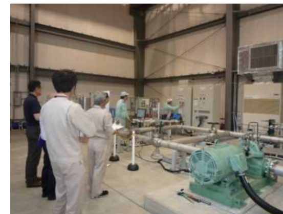
(模擬設備を用いた実技研修)
