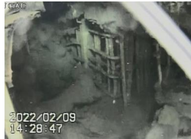
A. ペDESTAL開口部付近
