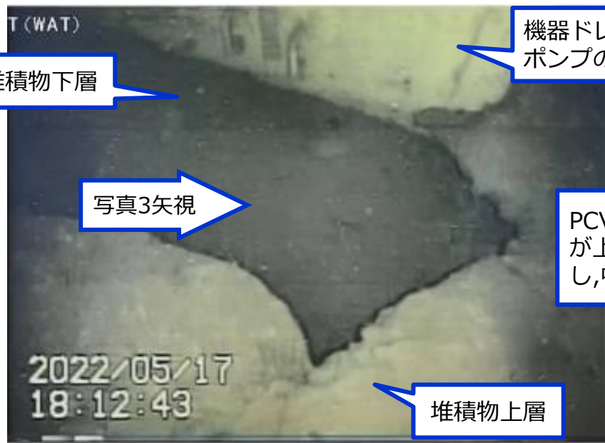
写真2.PCV底部の堆積物の状況
