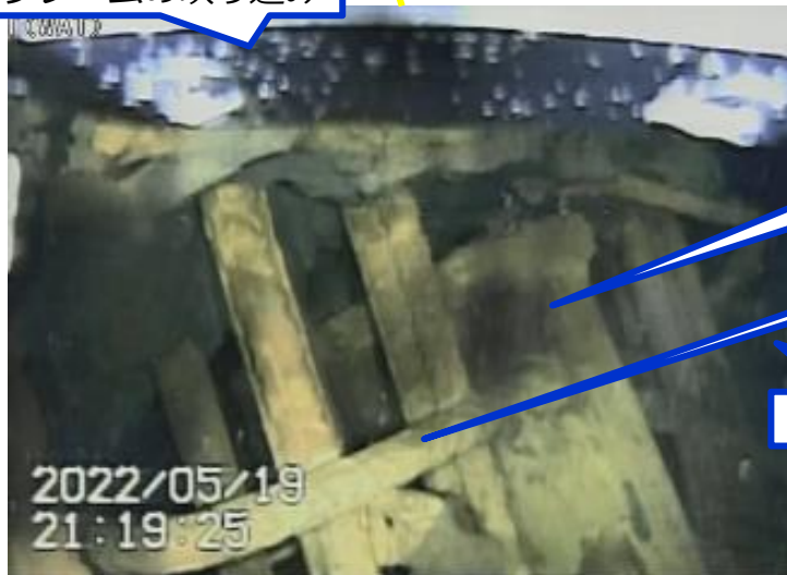
写真1.ペDESTAL開口部(左側基礎部)の状況
