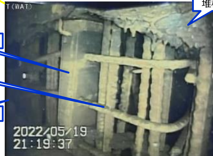
写真2.ペDESTAL開口部(右側基礎部)の状況
