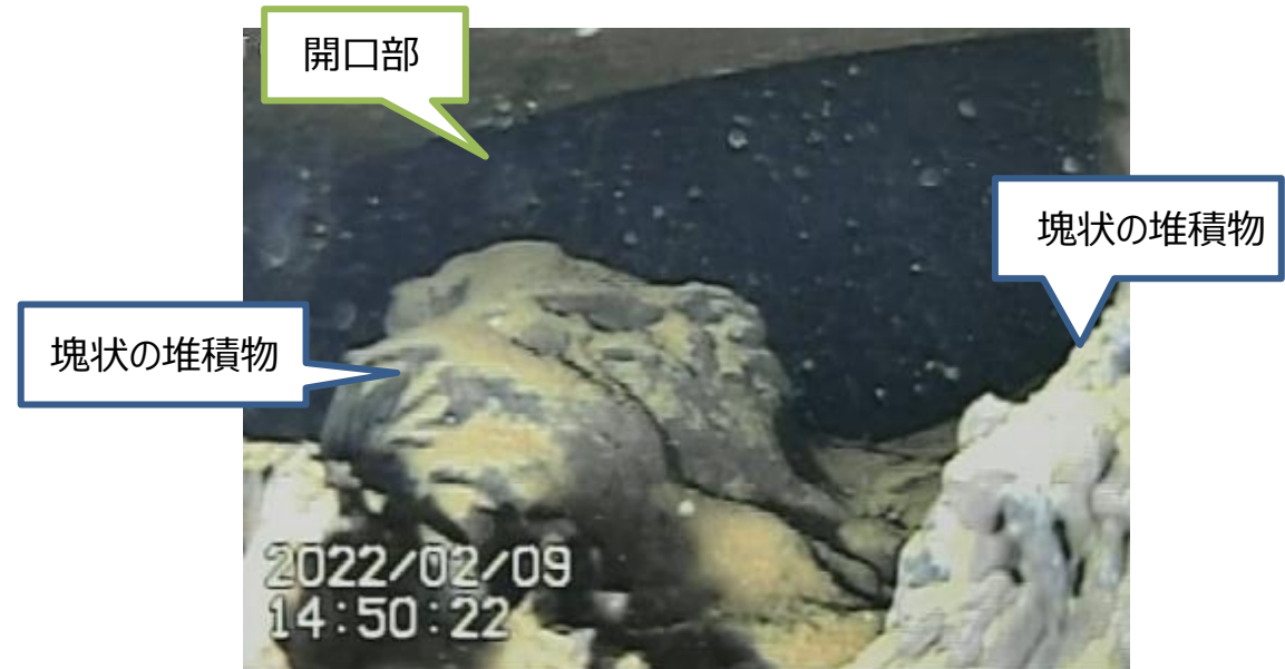
C. ペDESTAL開口部内部
