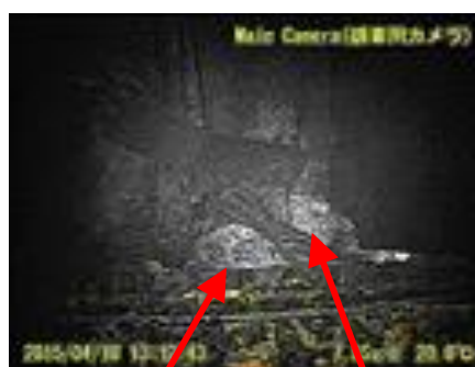
連結プレート 固定治具 溶融した鉛
