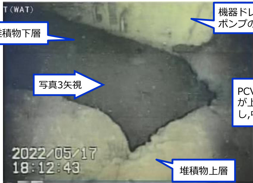
写真2.PCV底部の堆積物の状況
