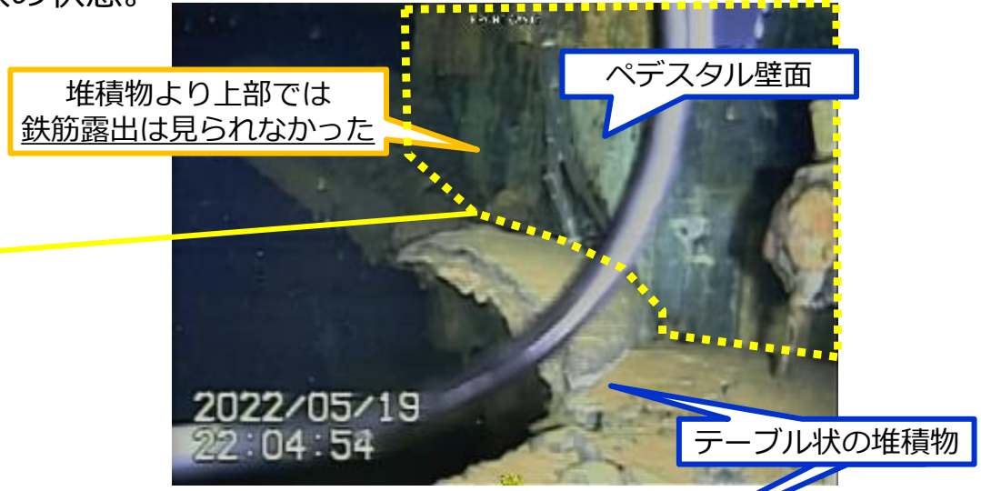
写真2.ペDESTAL開口部(右側基礎部)の堆積物より上部の状況
