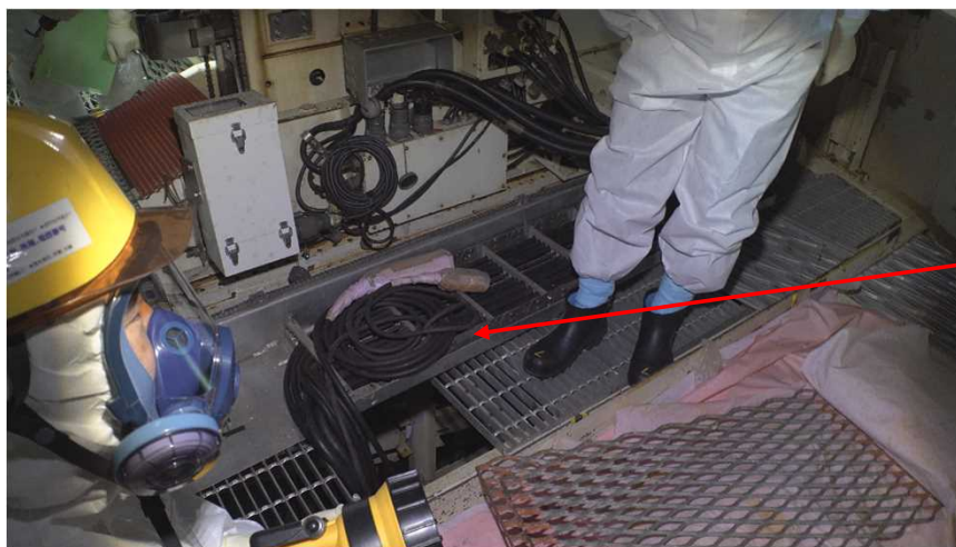
CRD交換機ケーブル(ペDESTAL内)
