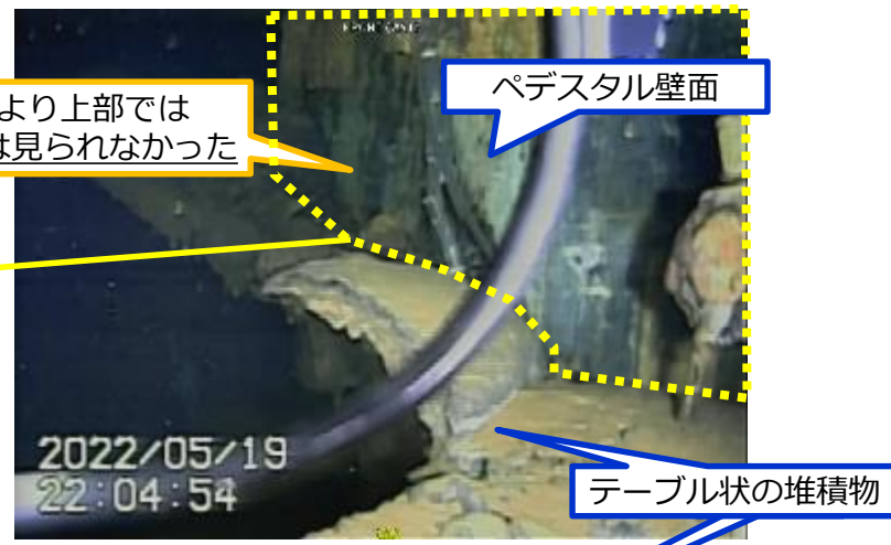
写真2.ペDESTAL開口部(右側基礎部)の堆積物より上部の状況
