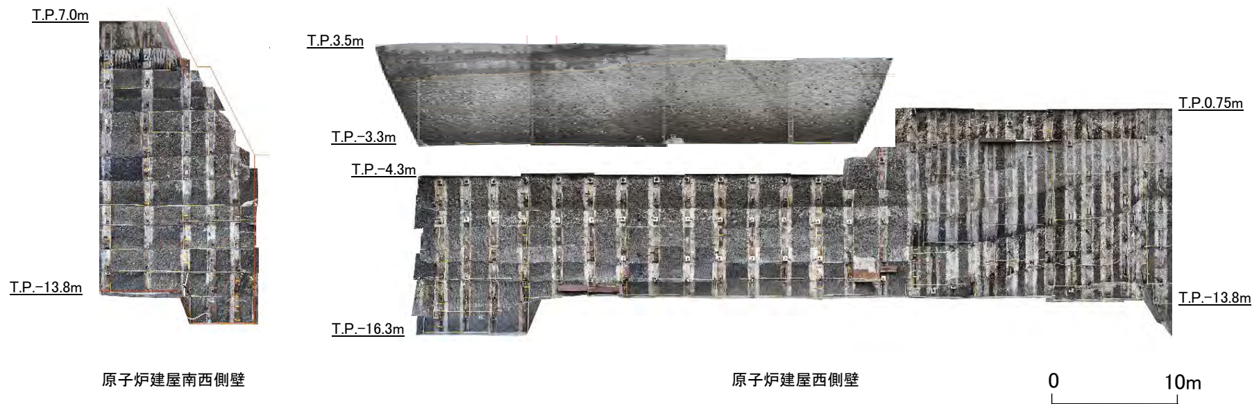
側壁地質図⑩～⑪～⑳ (原子炉建屋南西側壁～西側壁)における掘削面地質観察結果(法面写真)
