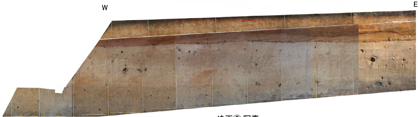
法面② 写真
