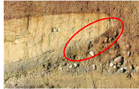
③ 3.5m西方法面
