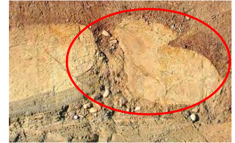
④ 5m西方法面
