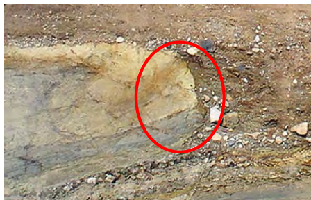
⑨ 12.5m西方法面
