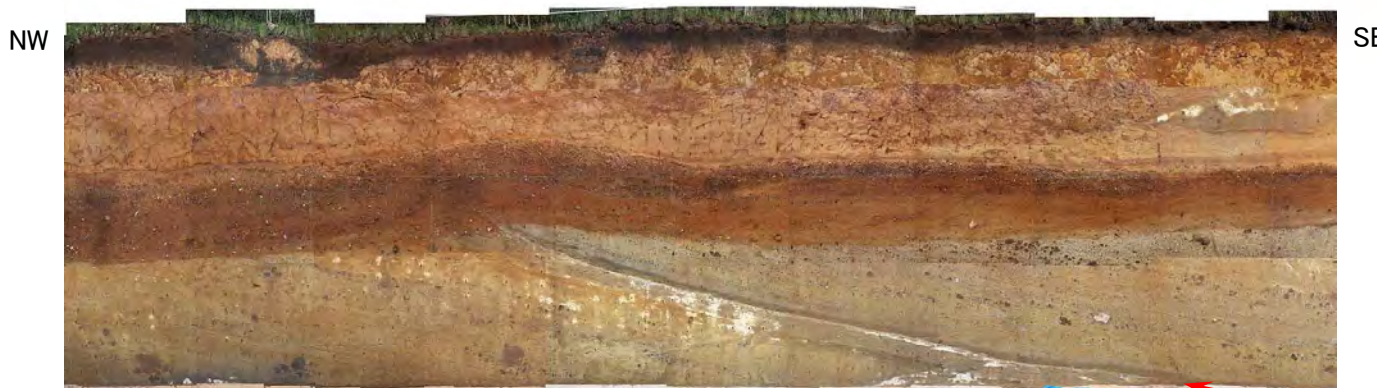
Ts-6法面写真
