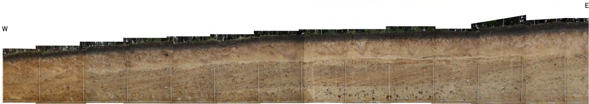
法面④ 写真
