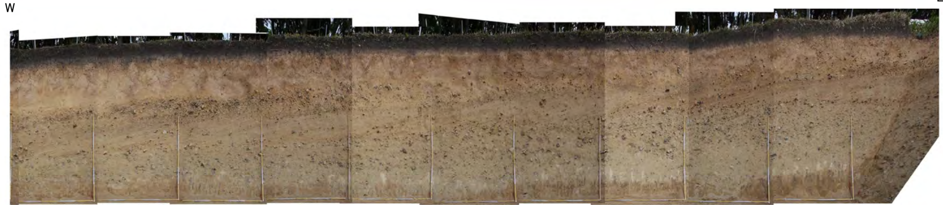
法面③ 写真
