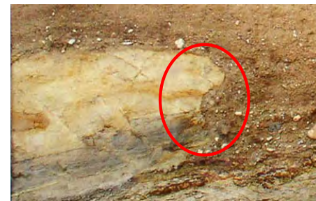
⑩ 14m西方法面
