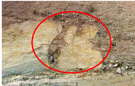
⑤ 6.5m西方法面
