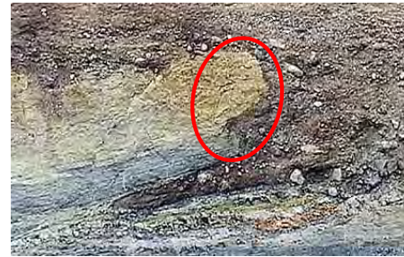
⑦ 9.5m西方法面
