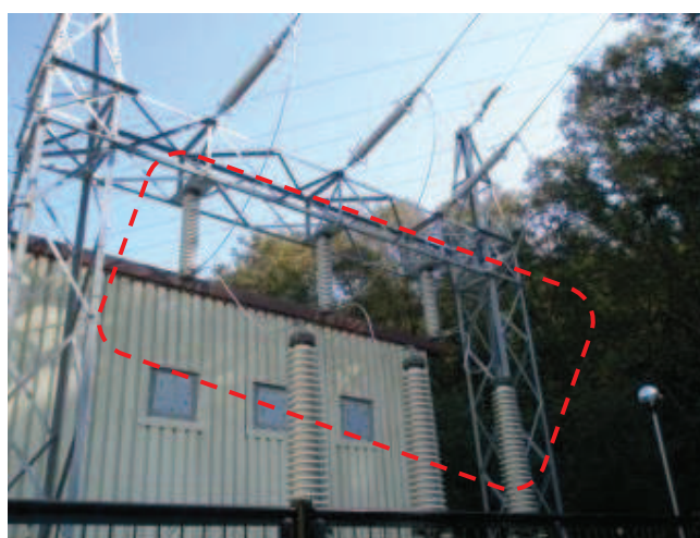
66kV 送電線引込み部（イメージ）
