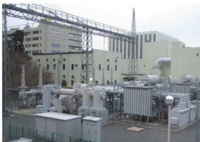
(ガス絶縁開閉装置イメージ)
