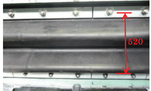
ゴムジョイント設置状況 (ボルト M20@200mm にて固定)
