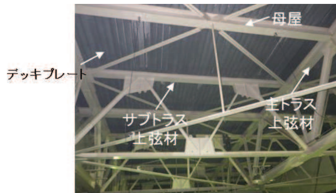
図 5.6-6 原子炉建屋原子炉棟天井の状況
