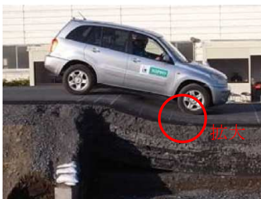
図9-12 不等沈下後における路面状況
