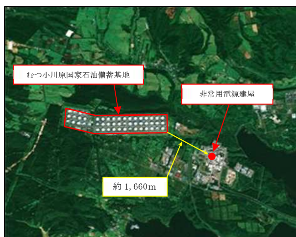
第 1.7.11-3 図 石油コンビナート等特別防災区域内の配置概要図
