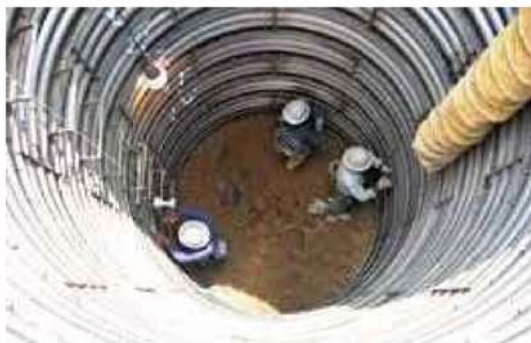
図 5.14.6-3 ライナープレート施工状況
