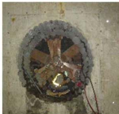
図 5.14.5-4 連続コアによる削孔
