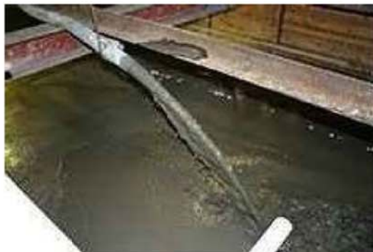
図 5.14.6-7 流動化処理土打設状況
