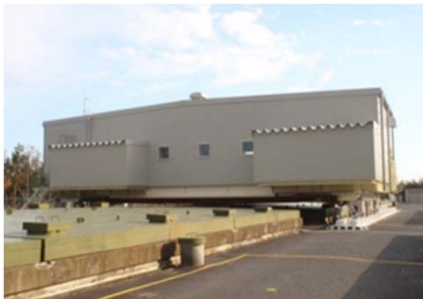
保管体取出装置 (1ピット全体を覆う構造)
