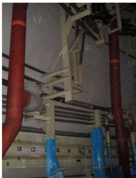
仮設足場組立前
