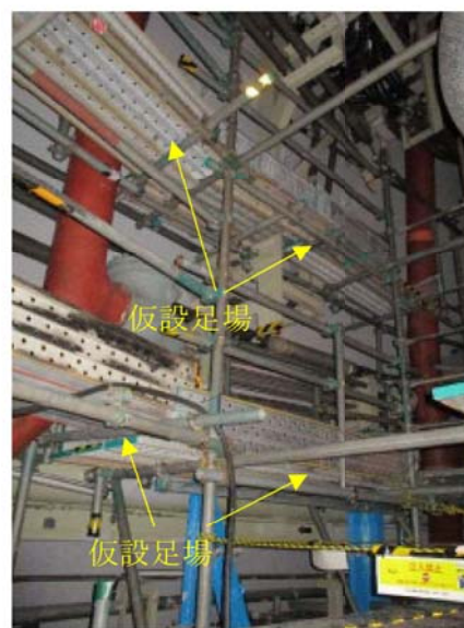
仮設足場組立後
