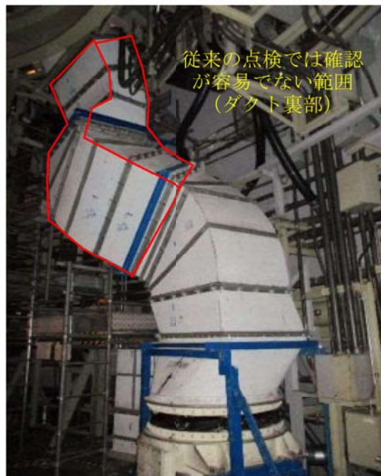
図 3. 7 従来の点検で確認が容易でない範囲（代表例）
