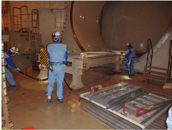
機器搬出入用レール取外し
