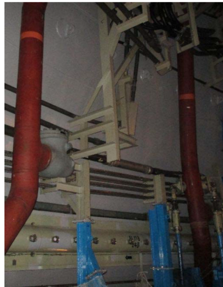
仮設足場組立前
