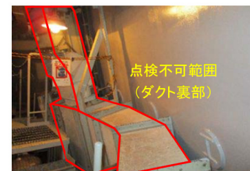
例 点検不可範囲 (ダクト裏部)
