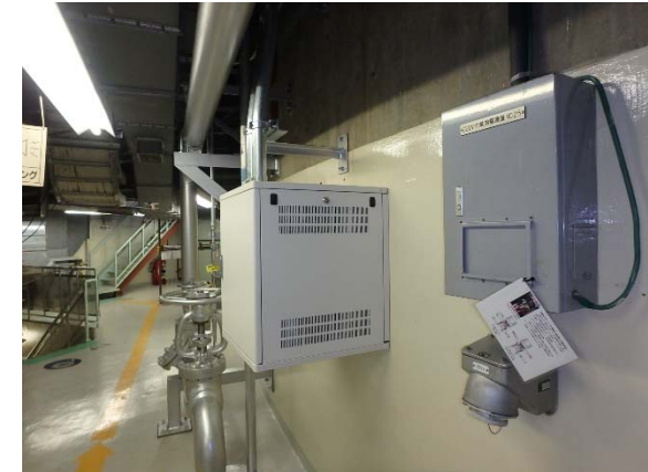
原子炉建屋等 一次遮蔽壁
