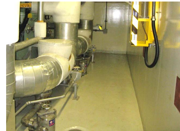
タービン建屋 基礎マット
