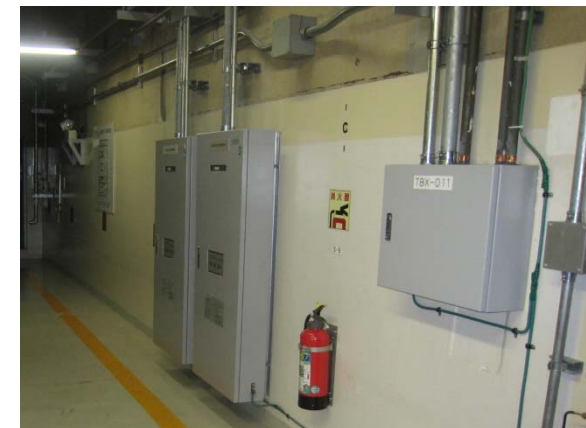
タービン建屋 外壁
