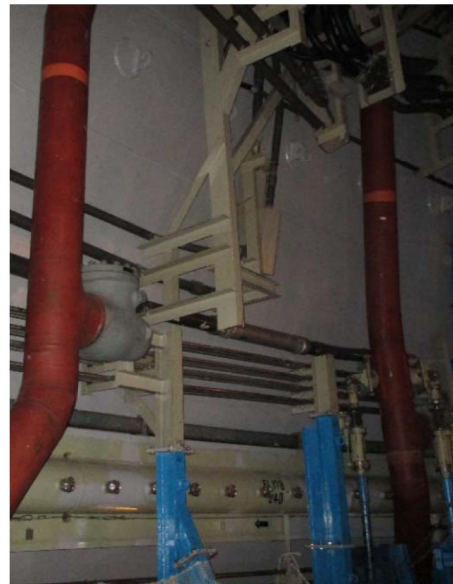
仮設足場組立前
