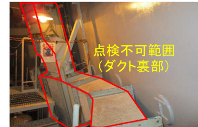
例 点検不可範囲(ダクト裏部)
