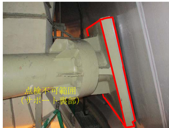
例 ドライウェル内面(気相部) 点検不可範囲
