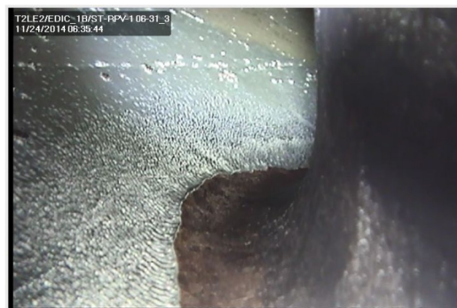
CRDスタブチューブの原子炉圧力容器取付け溶接部
