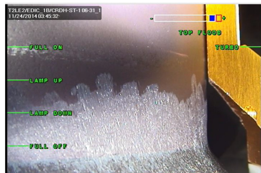
CRDハウジングのCRDスタブチューブとの溶接部
