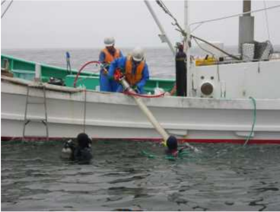
図 3 : バイブロコアラール・コアチューブ投入作業の状況.
