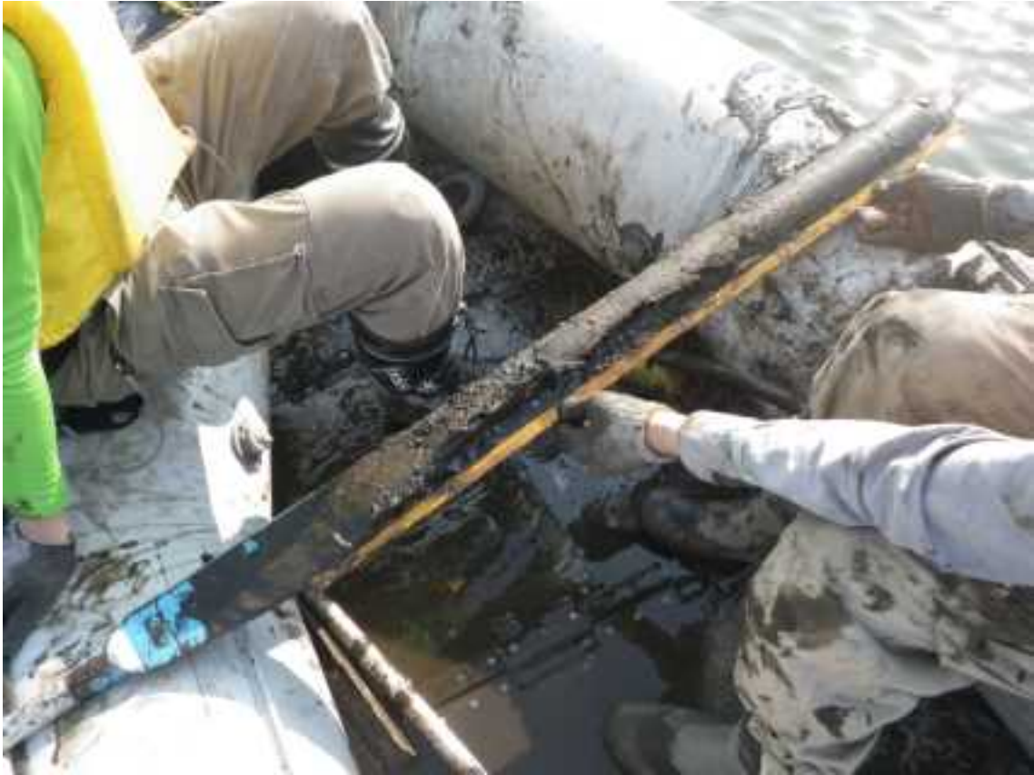
図 5 : 掘削作業の状況.
