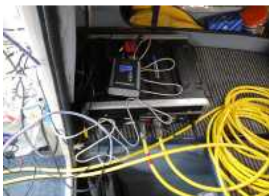
使用機器 測深システムの設置状況
