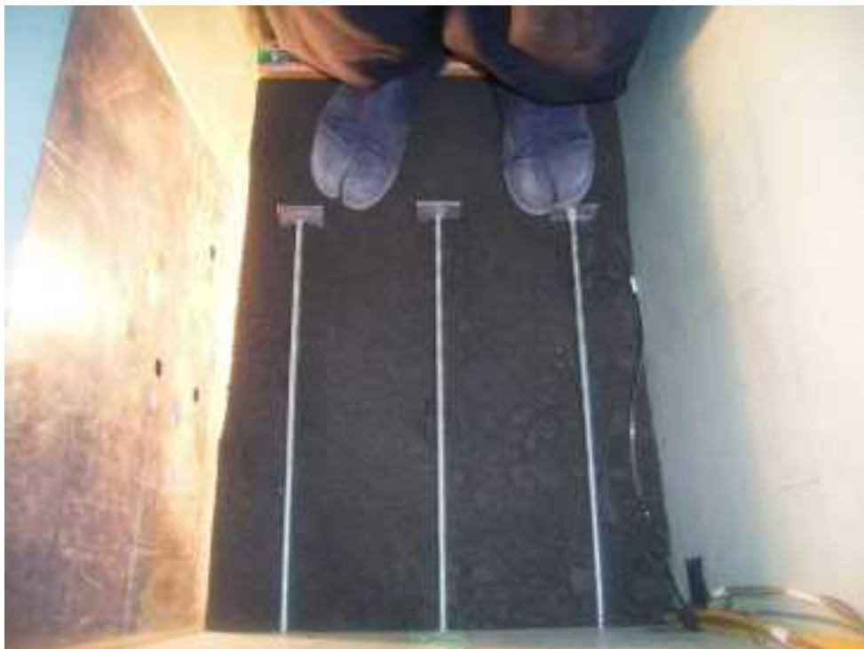
写真 3.1.7 剛体土槽を反力としたアンカー補強
