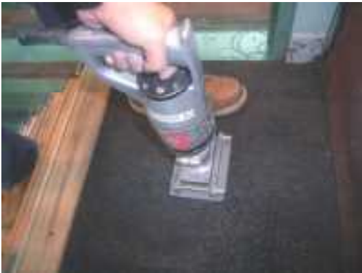
写真 3.2.8 締固め状況
