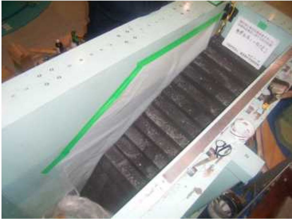
写真 3.1.4 摩擦低減層シート貼り 1
