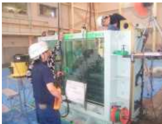
写真 3.2.4 スペーサー引抜き
