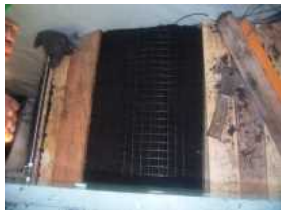
写真 3.1.11 表層部補強材敷設状況
