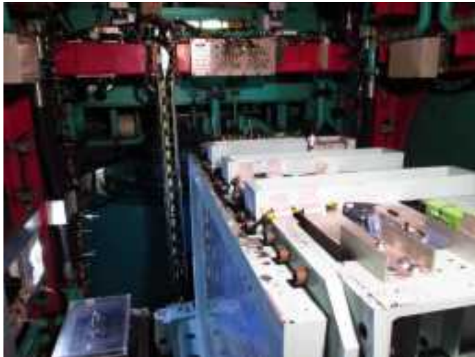
写真 4.1.2 ケーブル配線状況
