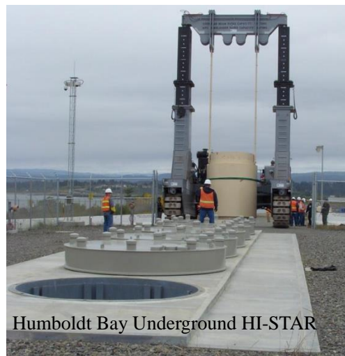
図 2.1.2-5 コンクリートキャスク例 (NWTRB 2010、NRC 2012a、Hanson 2102)
