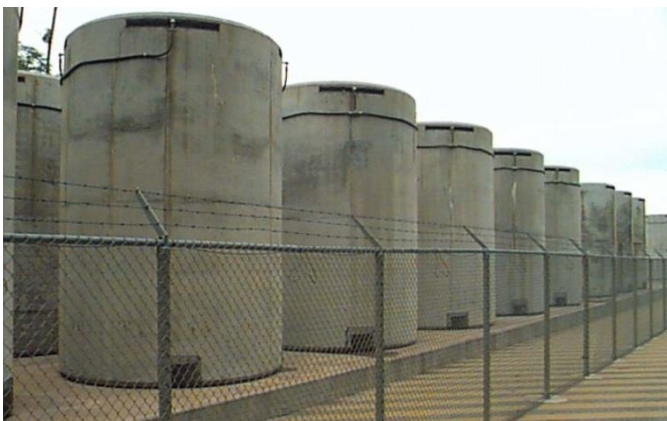
図 2.1.2-5 コンクリートキャスク例 (NWTRB 2010、NRC 2012a、Hanson 2102)
