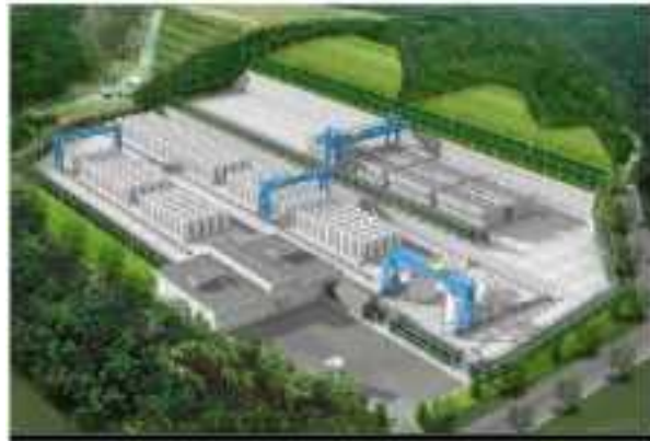
(a) 7M/K の 40 基のモジュール（右上）と 300 基のサイロで構成される月城の CANDU 炉 用使用済燃料の乾式貯蔵施設
