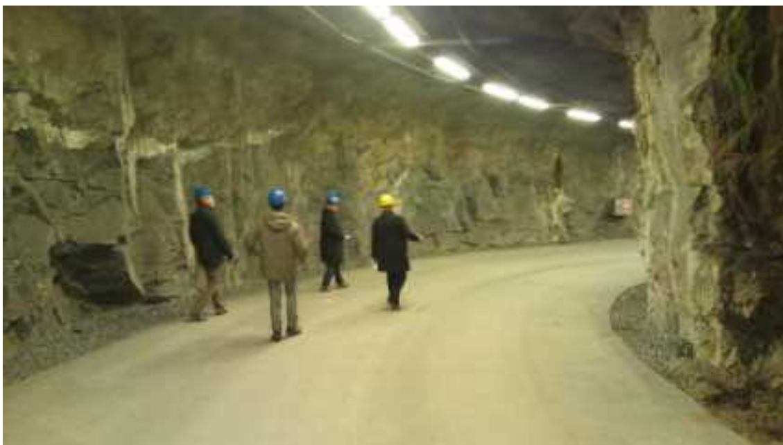
図 5-1 VLJ 処分場坑道内
