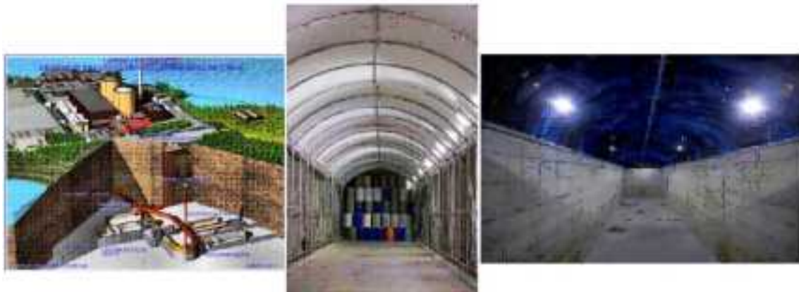
図 1.4-2 ロヴィーサ発電所処分場。LILW 用処分場と計画されている廃炉廃棄物用拡張部の断面図（左）、処分場坑道内の原子炉運転廃棄物の LLW 入りドラム缶（中）、廃棄物が置かれていない固体廃棄物用処分場坑道（右）
