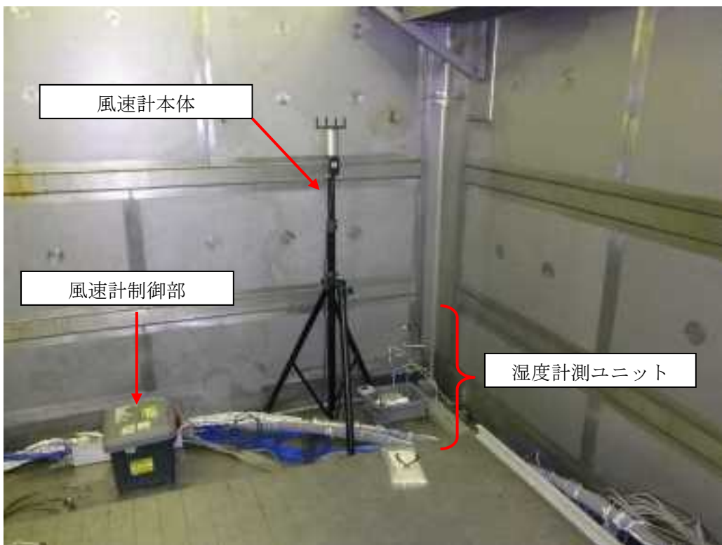
図 3. 4. 2-20 湿度計測ユニット及び風速計測システム
