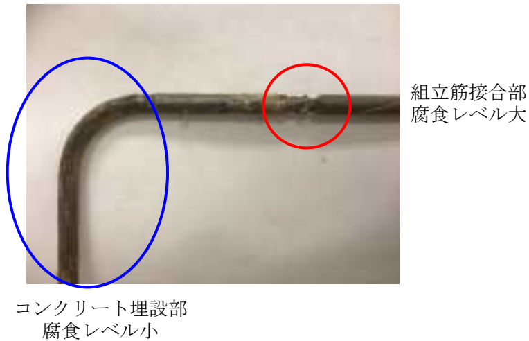
図 3. 4. 1-128 コンクリートから取り出した鉄筋の腐食状況
