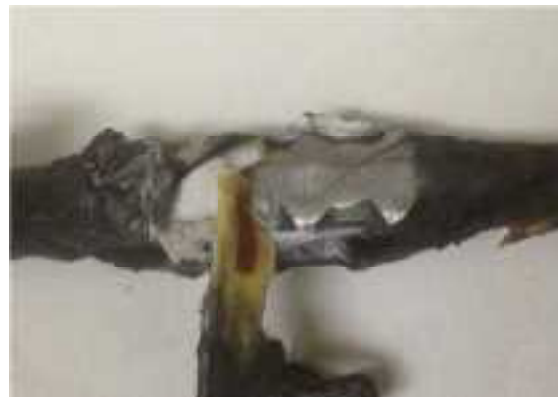
図 3.4.1-131 D10 裸鉄筋の促進腐食試験終了後の保護幅 20 mmゲージ
