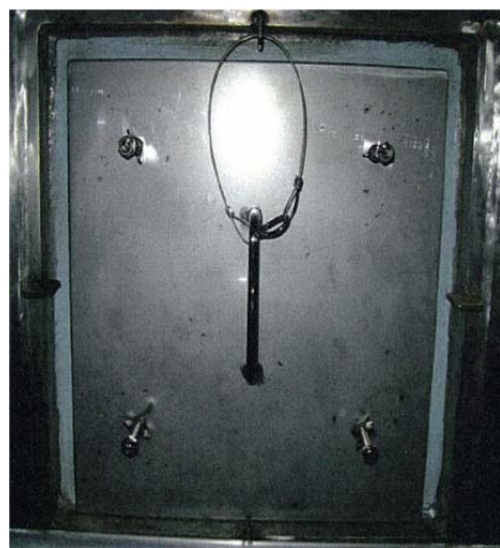
写真 燃料池水面側壁のダクト排気口の閉止板設置前と設置後 設置前の排気ダクト
