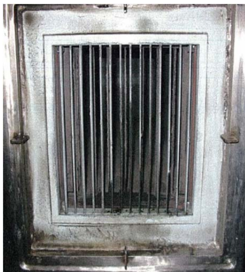
写真 燃料池水面側壁のダクト排気口の閉止板設置前と設置後 設置前の排気ダクト
