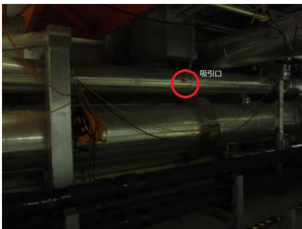
【写真 5】地下1階中間部南側付近の吸引口(サンプリング箇所)
