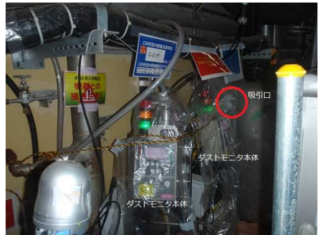
【写真 4】1号機タービン建屋1階南側付近に設置されたダストモニタ本体(2台)及び1階南側の吸引口(サンプリング箇所)
