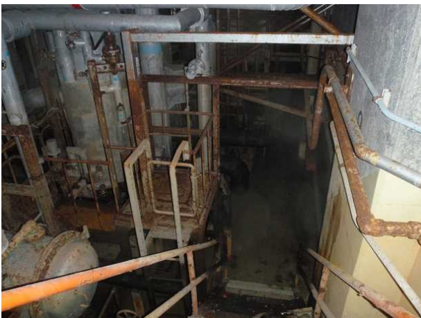
【写真1】1号機タービン建屋南側地下1階中間部南東側階段付近から、最下階を北側に向かって目視確認
