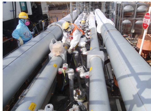
【写真2】 1号機R/B付近の“北側”での凍結管入口側の弁の操作状況
