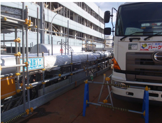
【写真1】 1号機R/B付近の“北側”全景
