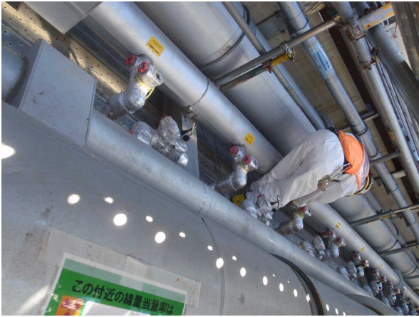
【写真3】2号機R/B付近の西②での凍結管入口側の弁の開操作状況
