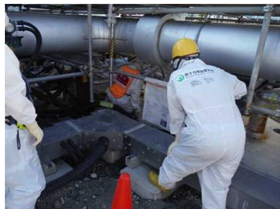
【写真2】4号機R/B付近の西⑤7ブロックでの凍結管の弁操作状況を確認。
