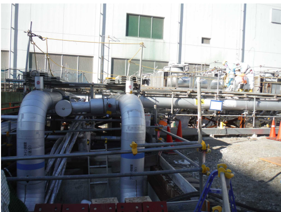
【写真1】4号機R/B付近の西⑤7ブロック全景。
