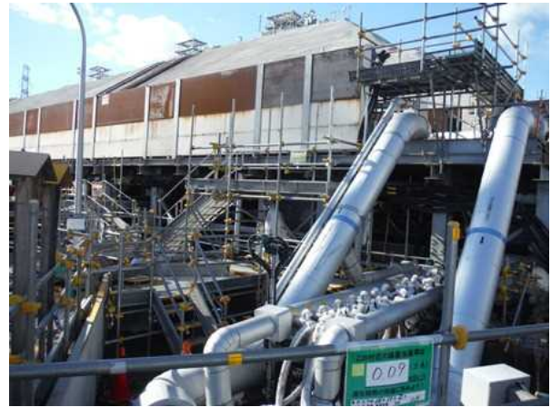
【写真 4】1号機R/B付近の西⑤ブロックの全景。
