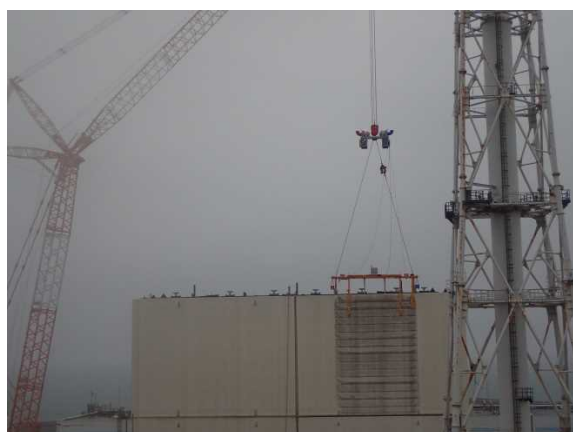
【写真1】 クレーンに吊られた治具をパネルに設置
