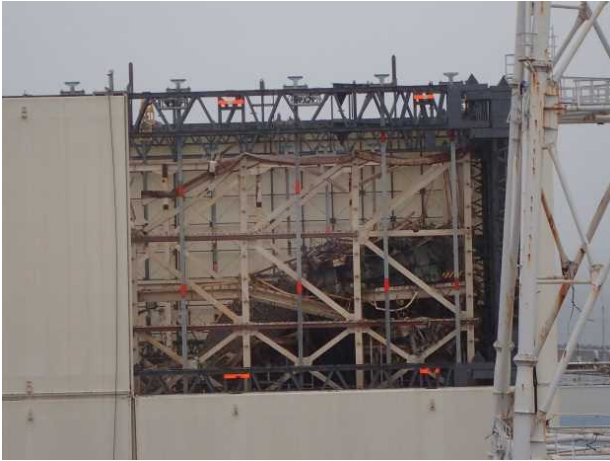
【写真3】1号機のパネルを取り外した部分
