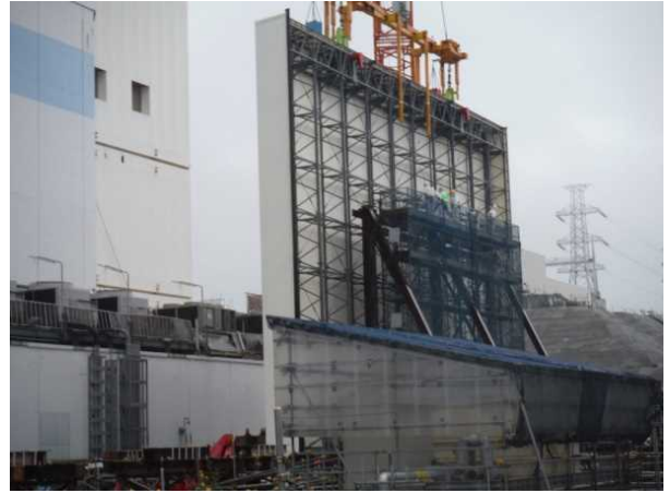
【写真4】降ろされたパネルの裏側
