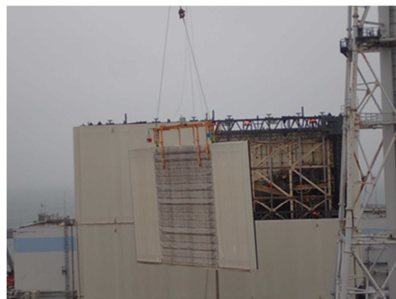
【写真2】 移動中のパネル
