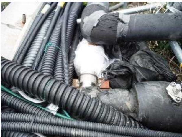
【写真 5】当該フランジ部の周囲に土嚢が設置されている。
