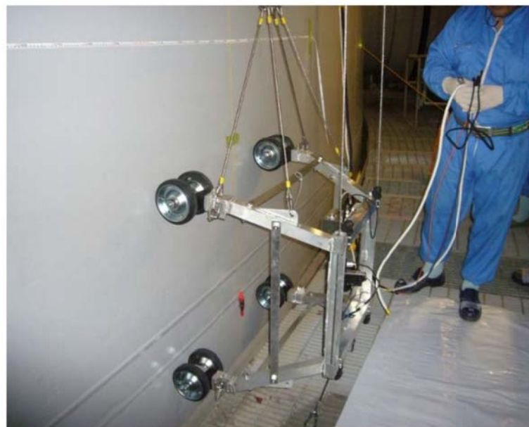
円筒部外面 遠隔目視用点検装置
