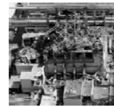
破壊された3号機原子炉建屋
