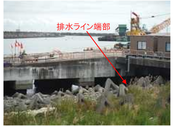
【写真 4】物揚場にある浄化水排水ライン排水端。
