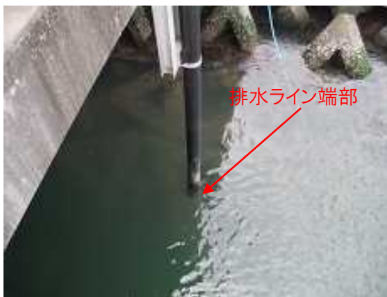
【写真 5】物揚場にある浄化水排水ライン排水端。
