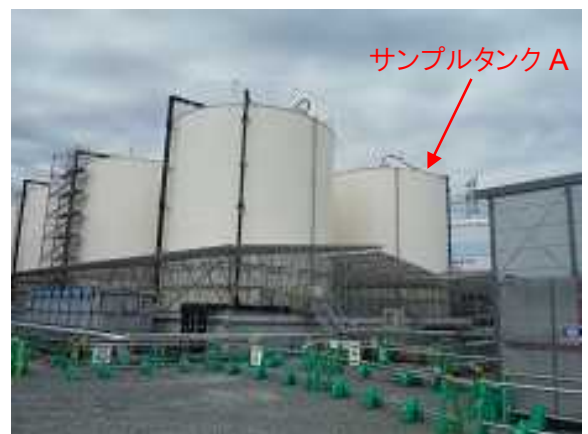
【写真 2】サンプルタンク群。右のプレハブ小屋内に浄化水移送ポンプがある。
